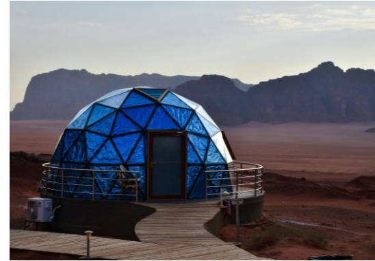
Dome Геодезическая конструкция с прочным распределением нагрузки, панорамным остеклением и отличной теплоизоляцией.
